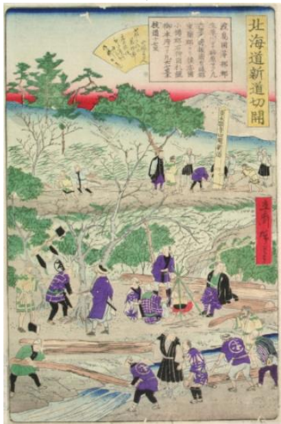
図4. 本願寺道路開削風景
