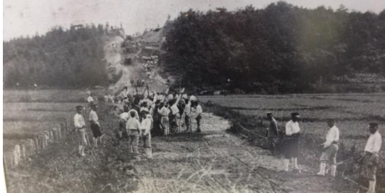
写真2. アンパン道路開削風景(今の南平岸交番付近から高台側を望んだところ)
